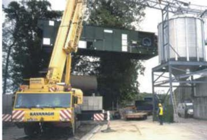
DF 42000 típusú szárítógép fő darabjának leemlése a kamionról és véglegese helyre történő helyezése
