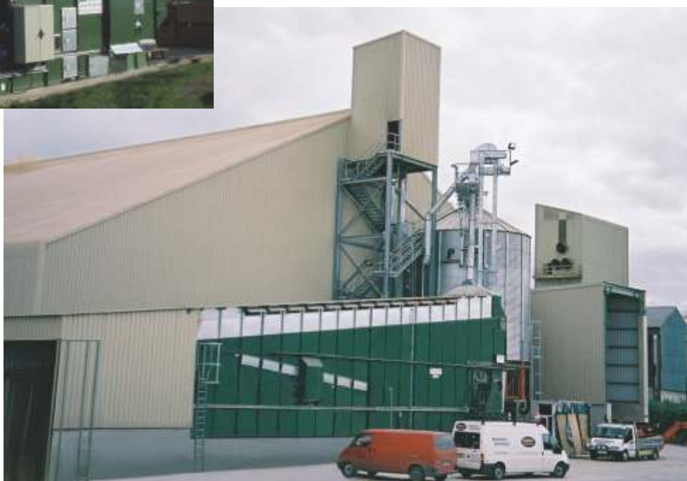
↑ Tipikus farmgazdasághoz méretezett szárítástechnika - DF 17750 szárító - 19,5 t/h
